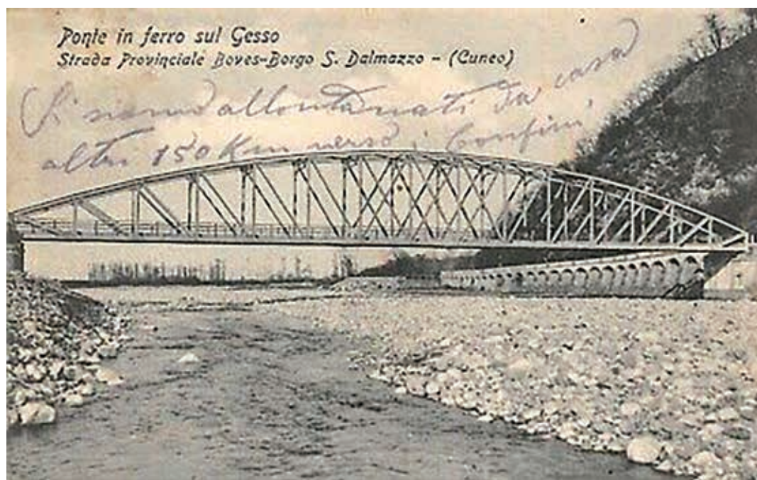
Fig. 1| Ponte del Ciadel – Foto storica di repertorio
