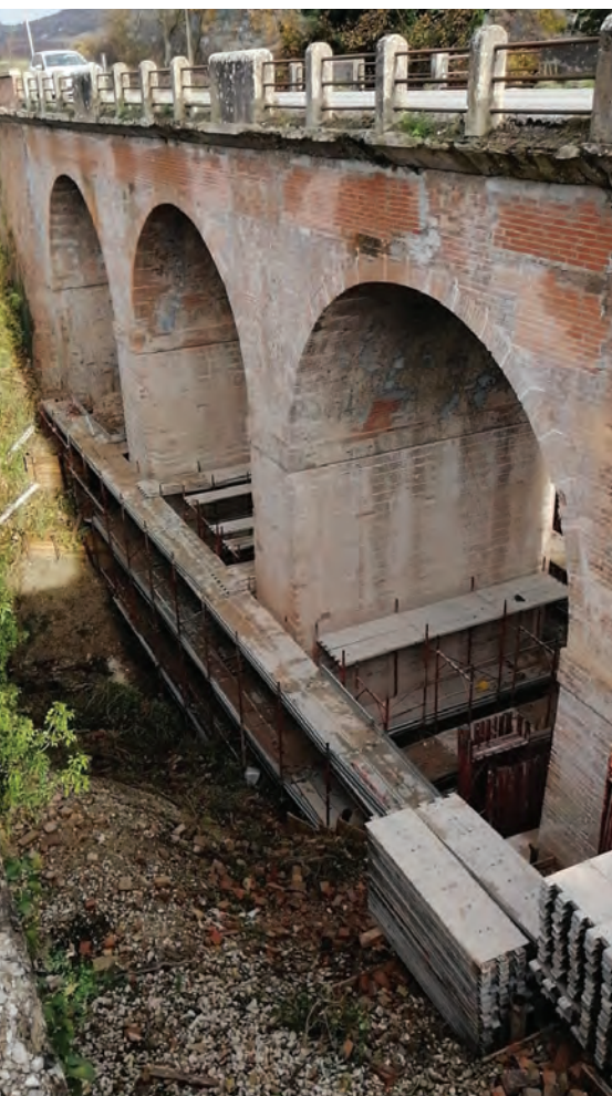
A sinistra, Ponte Sassoferatto messo in sicurezza A destra, Sassoferatto: sezione longitudinale
