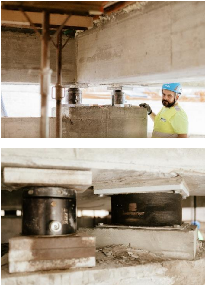
Fig. 5 – La messa a in opera dell'isolatore sismico
