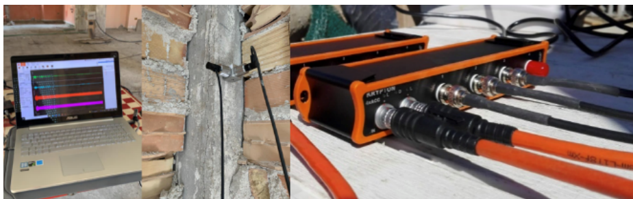
Fig. 7 - Centralina di acquisizione, stazione di acquisizione e accelerometri piezoelettrici.
